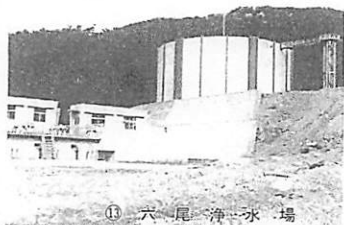
⑬ 六尾川浄水場
