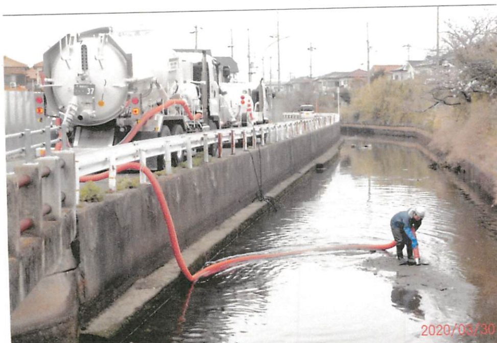
バキューム車によるヘドロ吸引作業
